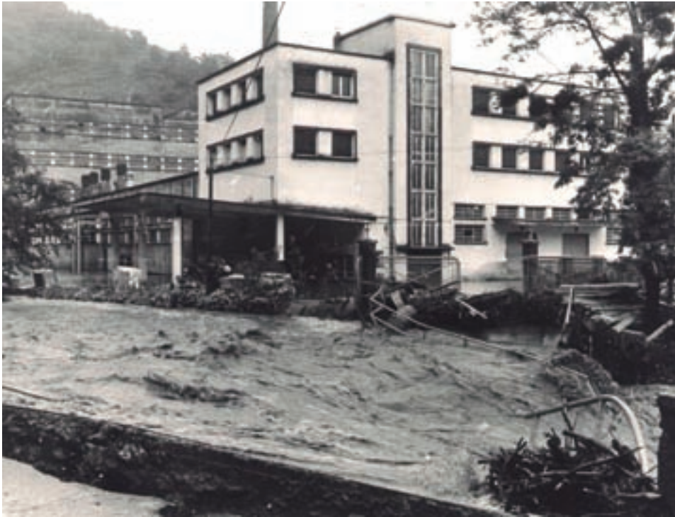
Imagen del 27 de agosto de la fábrica de Papelera del Leizarán, S.A. afectada por las inundaciones. Fuente: AMA, 4910XX01 (1983).
